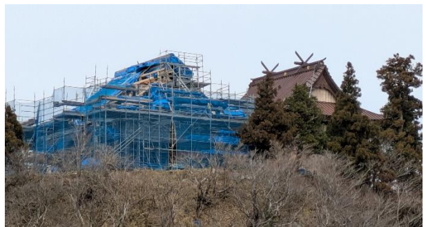
図2 修復工事中の上宮
