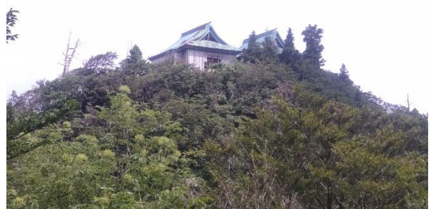
現在、修復工事中の上宮
