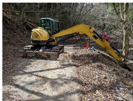
大南線工事現場
