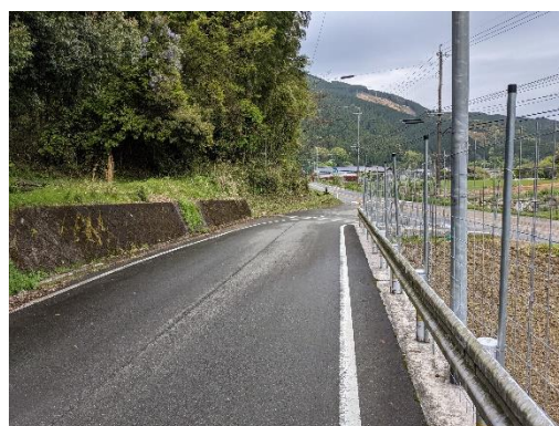
県道52号と合流、左へ進む
